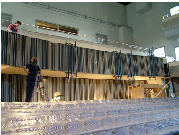
Figure 20. Montáž QRD difusorů na zadní stěně
