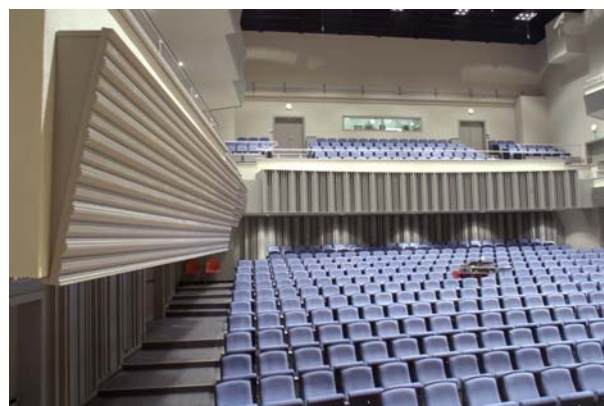
Figure 23. Pohled na akustické řešení interiéru, detail na umístění odrazně-rozptylných struktur na bočních balkónech
